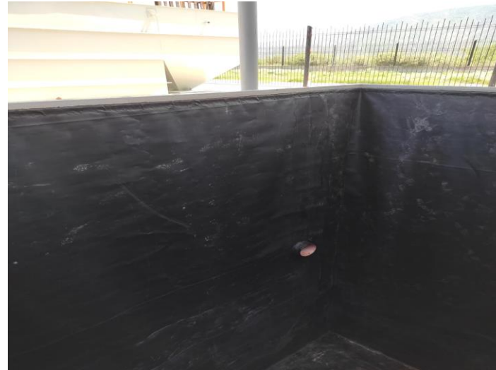
RECUBRIMIENTO DE CARCAMOS
