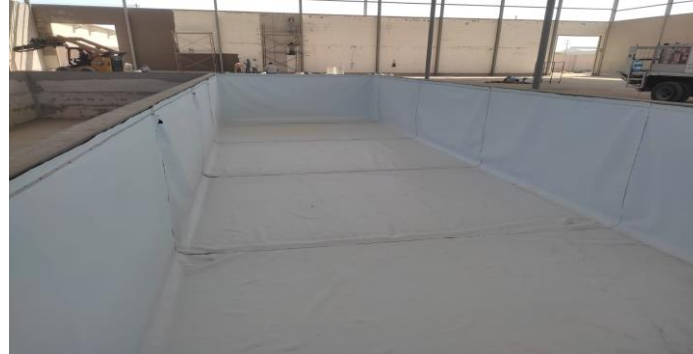
RECUBRIMIENTO DE CISTERNAS DE CONCRETO
