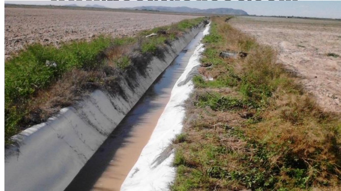
RECUBRIMIENTO DE ACEQUIAS CONDUCCION DE AGUA
