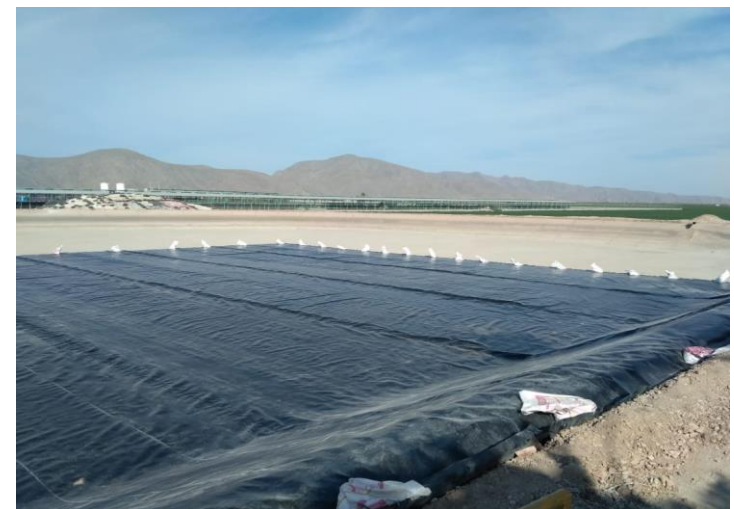
REABILITACION DE ESTANQUES DE CONCRETO
