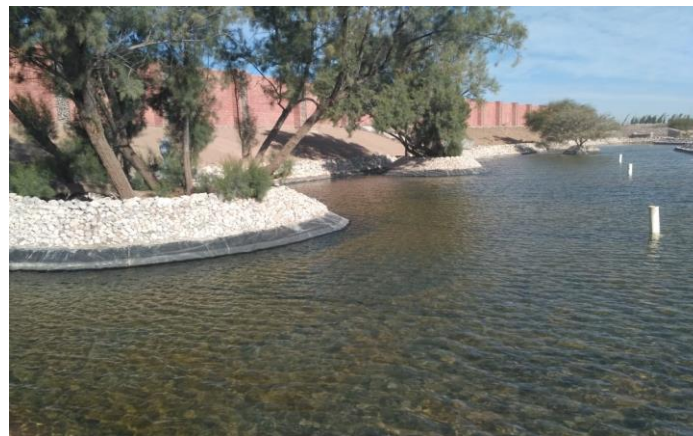
RECUBRIMIENTO DE LAGOS ARTIFICIALES
