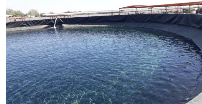
RECUBRIMIENTO DE ESTANQUES AGRICOLAS
